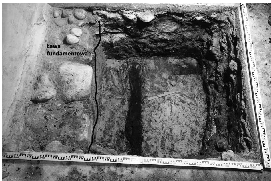
Ryc. 3. P1, piwnica w kamienicy Esterki, pozostałości drewnianego budynku oraz fundament łąwy fundamentowej kamienicy
