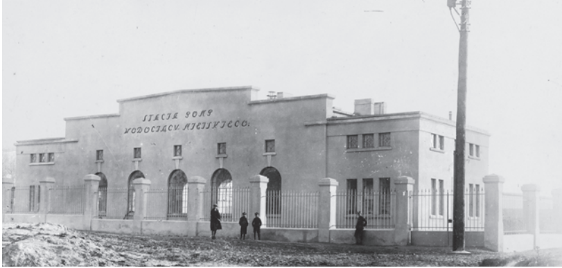
Fot. 17. Stacja pomp
