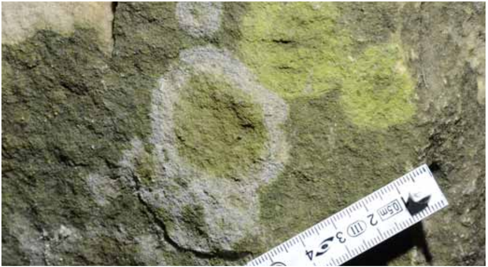
Fot. 5. Fragment kamieniarki renesansowej z piaskowca – powierzchnia pokryta glonami (Pierwotek Desmococcus sp.) oraz sinicami ( Cyanobacteria indet.) za G. Skrzyński 2012 (fot. R. Wilczyński).
