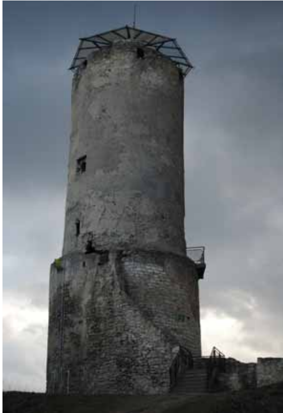
Fot. 1. Wieża zamku górnego w Iłży. Widok od strony N. Stan na 2012 r. (fot. R. Zapłata)
