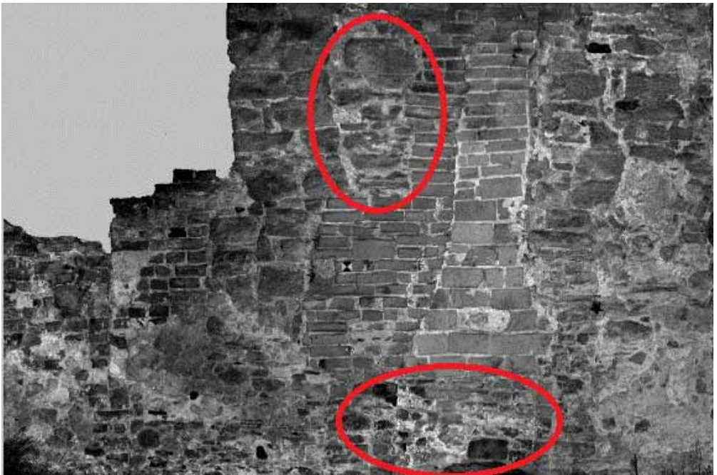
Foto. 6. Ortofotografia powierzchni ściany N pomieszczenia nr 5 (wg lustracji z 1644 r.) na bazie pomiaru przestrzennego oraz intensywności odbicia wiązki lasera - z zaznaczonymi wykwitami soli (dolne zakreślenie) oraz słabo rozpoznawalnymi fragmentami muru (górne zakreślenie). Stan na 2013 r. (Oprac. J. Markiewicz / wykonawca pomiaru Politechnika Warszawska / własność UKSW).
